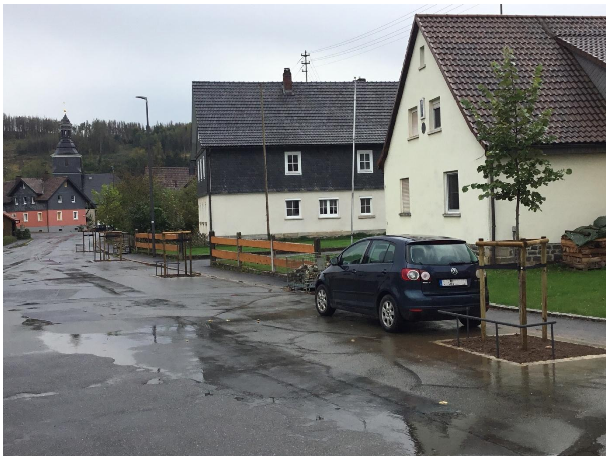
Abbildung 18: Begrünung der Dorfstraße in Welitsch (Heiko Kopp, 2024)
