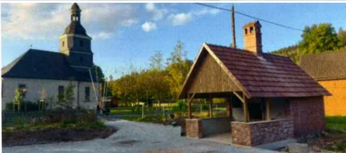
Abbildung 15: Sanierung Backhaus (Frank Müller, 2024)
