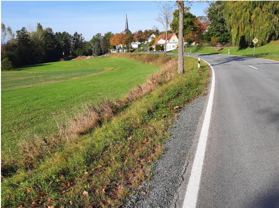
Abbildung 6: Entwässerung KC5 über Böschung ins Gelände
